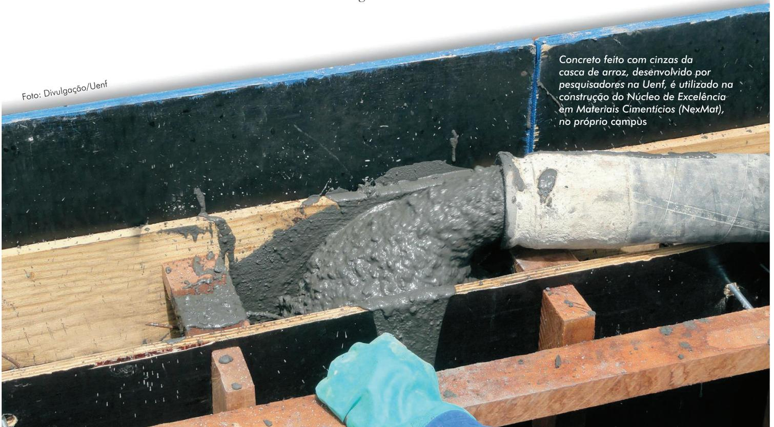
Concreto feito com cinzas da casca de arroz, desenvolvido por pesquisadores na Uenf, é utilizado na construção do Núcleo de Excelência em Materiais Cimentícios (NexMat), no próprio câmpus
